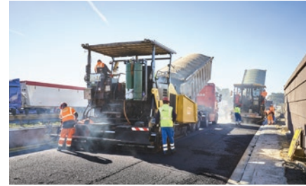
Réfection de la chaussée.
