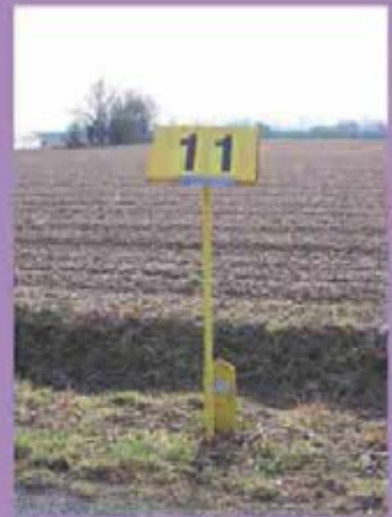
Borne de localisation d'un pipeline (© Alp'Géorisques)
