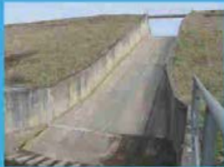
Barrage de Gloule (© DDTM40 - SPE)
