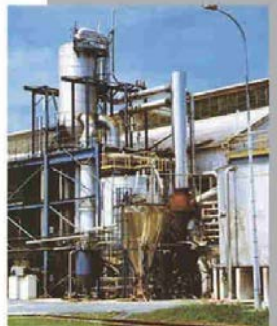
Usine saline de Saint-Pandelon (© www.salins.fr)
