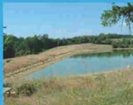
Barrage de Arthez (© DDTM40 - SPE)
